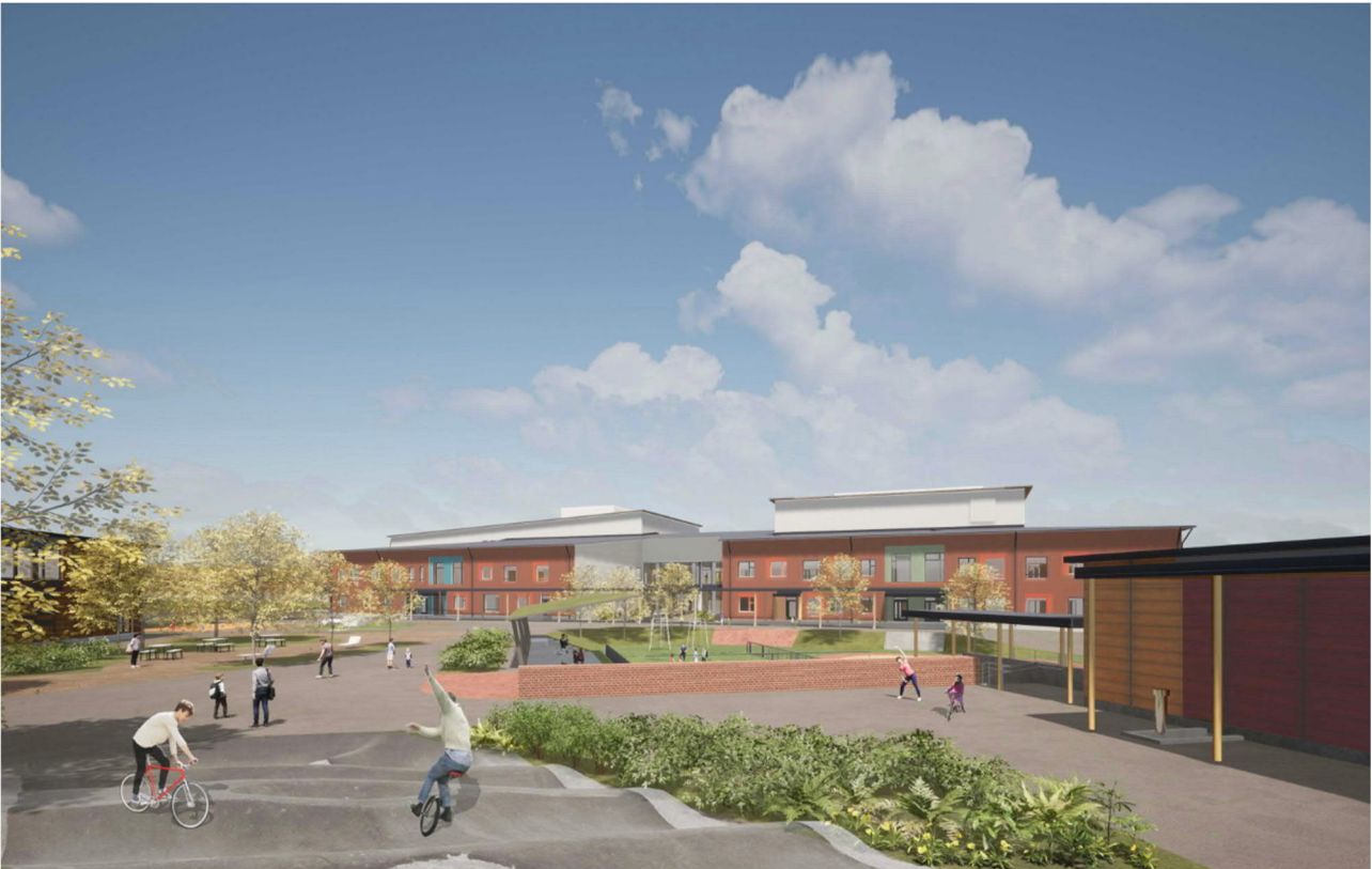
Kuva: Arsatek Oy, Riihikallion monitoimikampus
