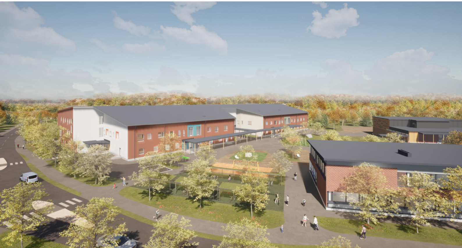
Kuva: Arsatek Oy, Riihikallion monitoimikampus
